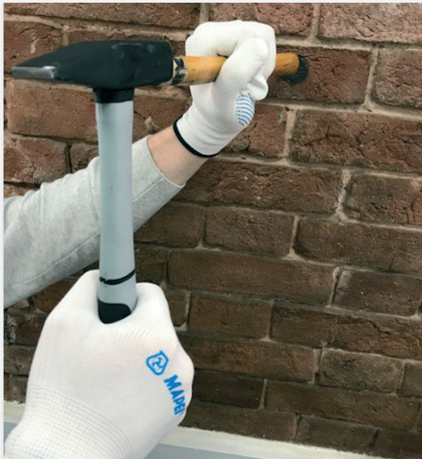
Рис. 18 Восстановление кладки способом уплотнения (трамбовки) жесткой смесью в нишах с естественными границами или границами полностью или частично сформированными опалубкой или в отверстиях.
