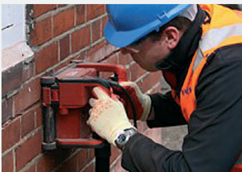
Рис. 11 Устройство штрабы на глубину 25-35мм.
