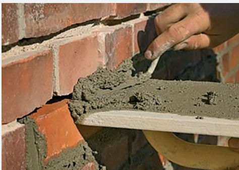
Рис. 10 Ремонт швов
