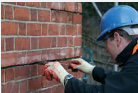
Рис. 15 Установка арматуры в раствор
