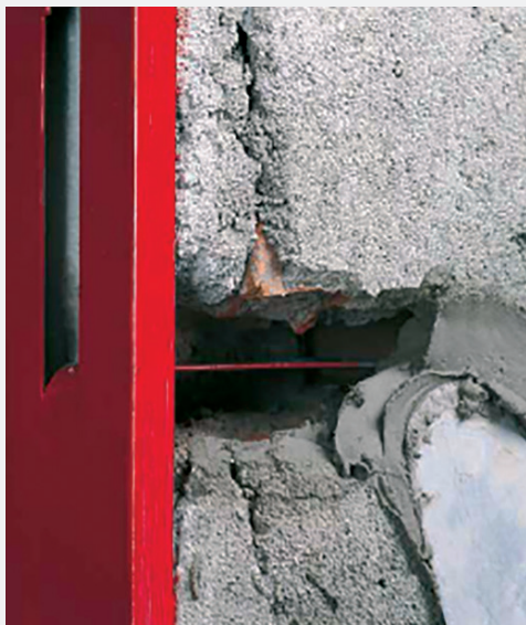
Рис. 4 Lampecem для фиксации закладных деталей в кладке
