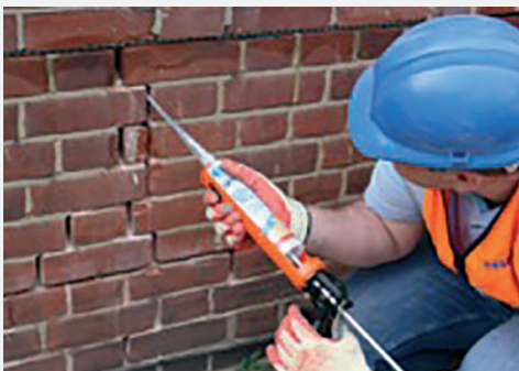
Рис. 14 Заделка трещины Mapeflex AC4 (выпускается белого или серого цвета. Можно красить)
