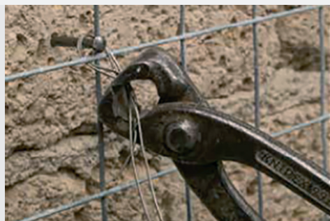
Рис. 6 Фиксация металлической сетки в проектном положении
