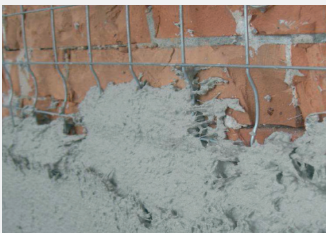
Рис. 9 Объемная сварная сетка с фиксированным отступом от основания.
