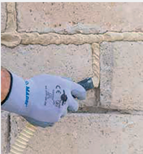
Рис. 21 Механизированное заполнение швов при ремонте.
