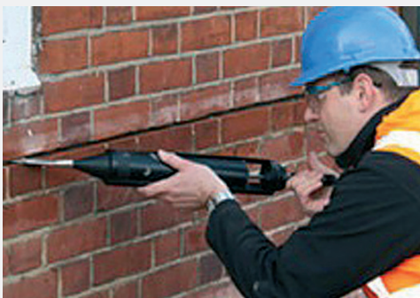
Рис. 12 Укладка монтажного раствора из пистолета
