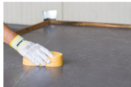
Очистка поверхности плитки
