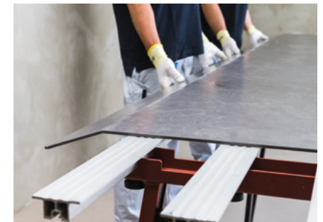
Плитка ломается на две части
