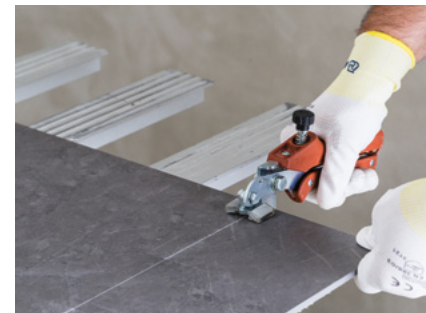
Разламывание плитки с помощью щипцов для надлома
