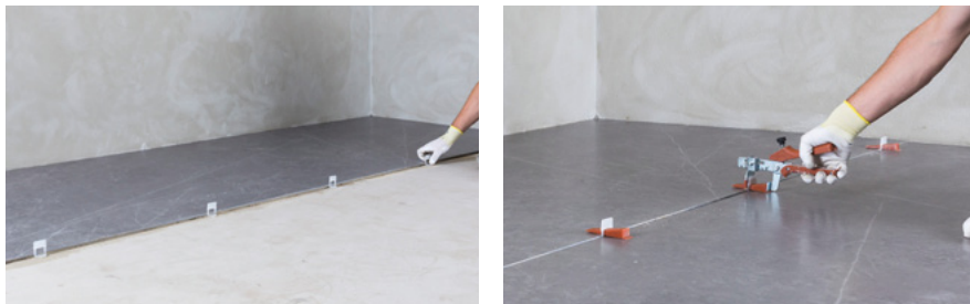
Установка разделителей в требуемое положение
