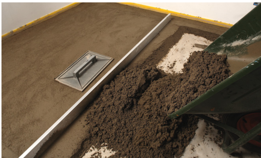
Укладка стяжки на основе Topcem Pronto
