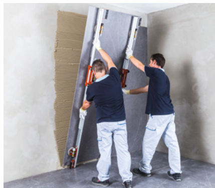
Укладка плитки на стену
