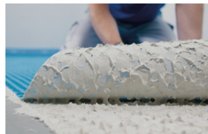
Процесс укладки Mapeguard UM 35
