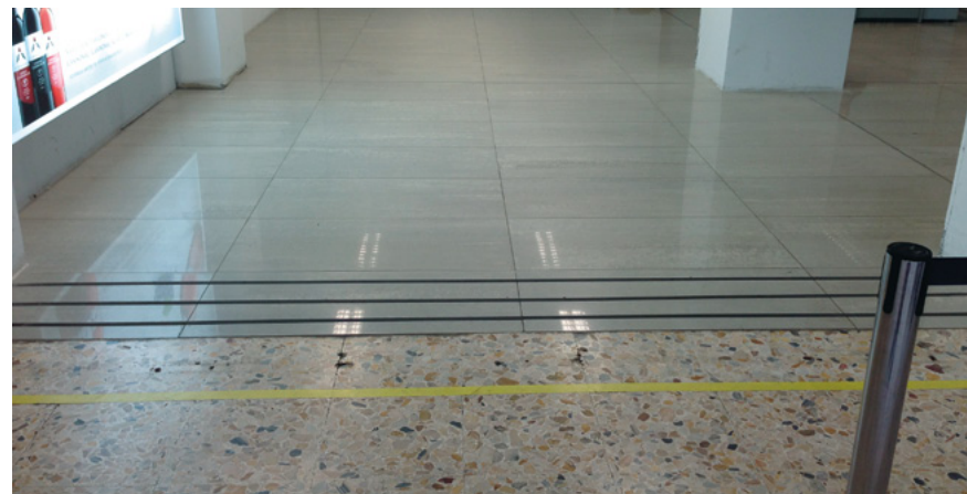
Укладка плитки поверх существующих полов
