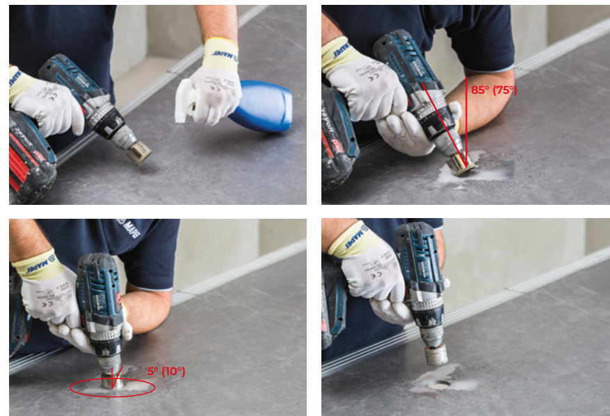
Порядок действий по созданию круглого отверстия
