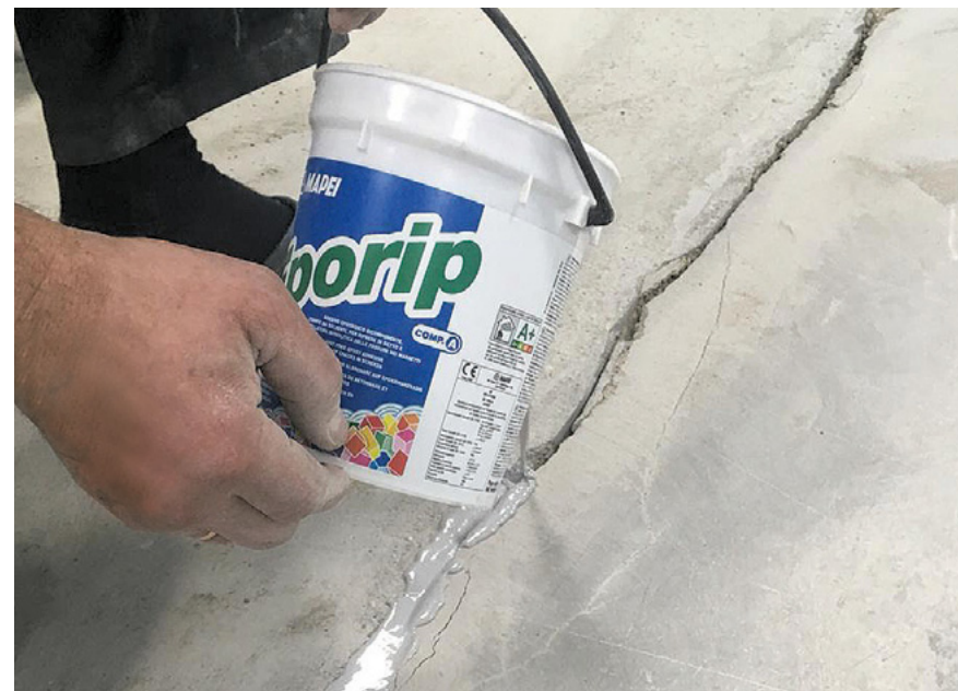
Заливка трещин в основании с помощью Eporip
