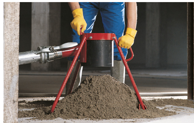
Укладка стяжки с помощью Topcem Pronto
