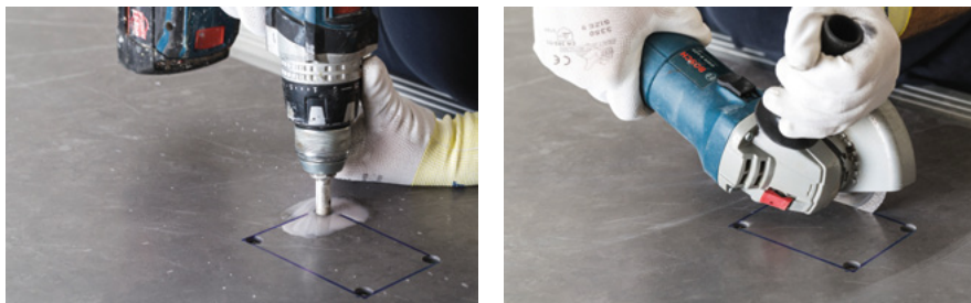
Порядок действий по созданию прямоугольного отверстия
