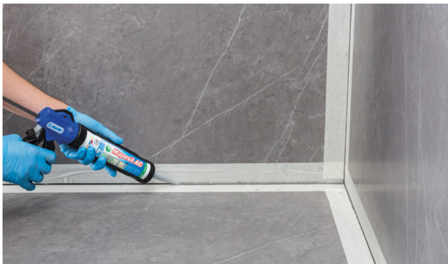
Герметизация шва по периметру с помощью Mapesil AC
