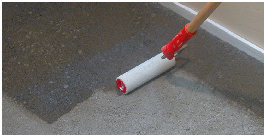
Нанесение Primer G
