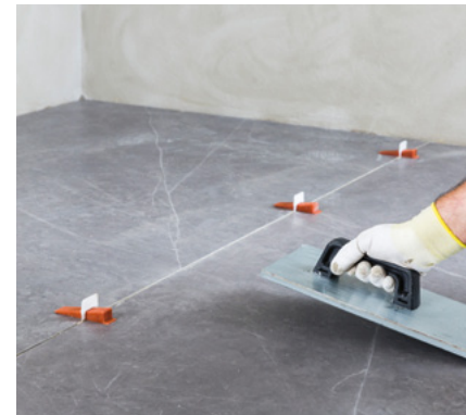
Простукивание плитки вручную или с помощью вибропанели
